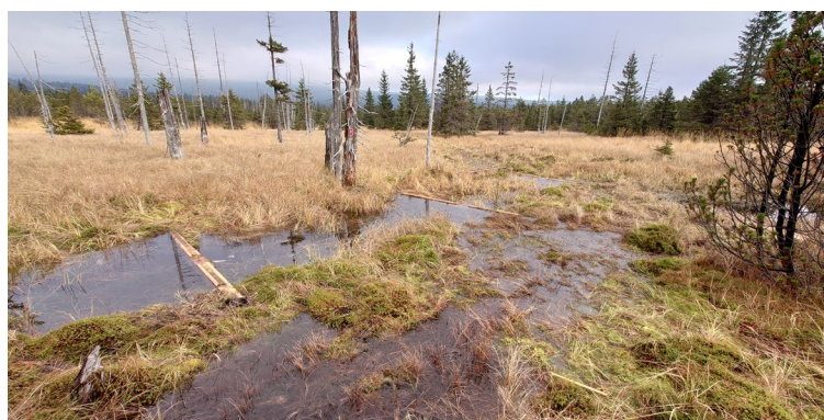
Revitalizace odvodňovacích příkopů a erozních rýh v EVL Rašeliniště Jizery, foto: Martin Kolář
